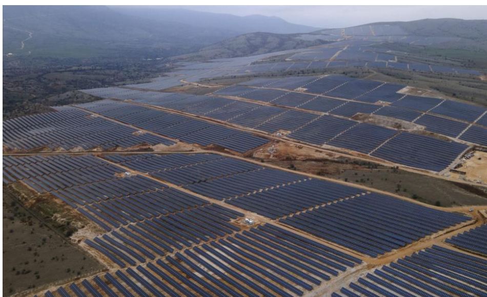
Σχήμα 26. Το φωτοβολταϊκό πάρκο της Κοζάνης
