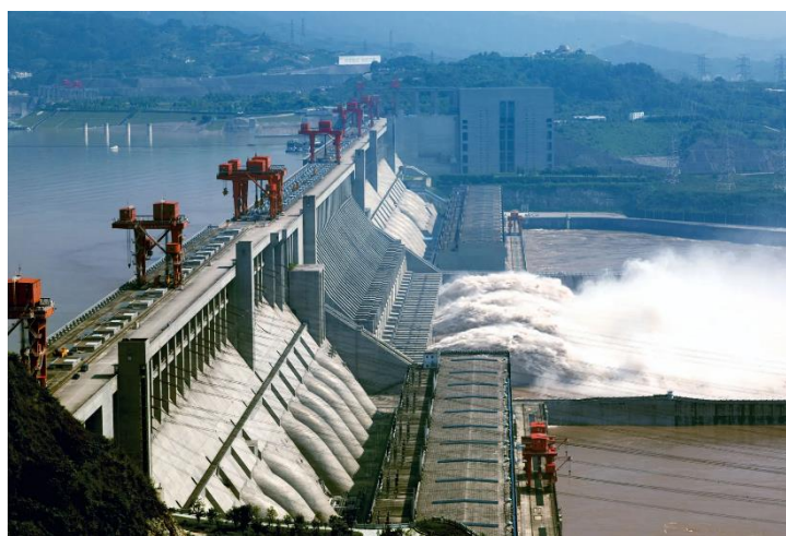
Εικόνα 1-7 Υδροηλεκτρικό Εργοστάσιο "Three Gorges Corporation"
