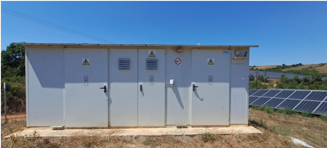
Εικόνα 1-15 Οικίσκος/Υποσταθμός
