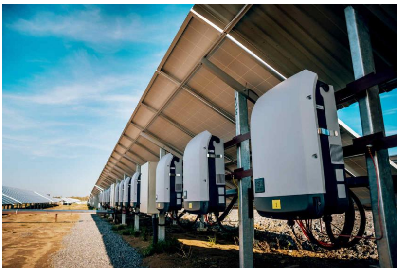
Εικόνα 1-14 Αντιστροφέας (Inverter) - Αντιστροφή ρεύματος από DC σε AC
