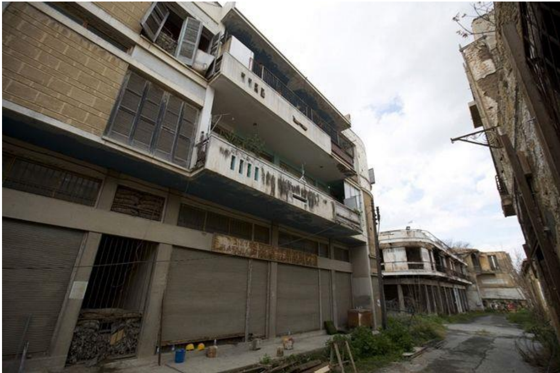
Εικόνα 56: Σπίτια κατεστραμμένα κοντά στην τοποθεσία «Μνημείο της Σελήνης», Νεκρή Ζώνη, Λευκωσία, Κύπρος. Πηγή: https://www.news247.gr/ .
