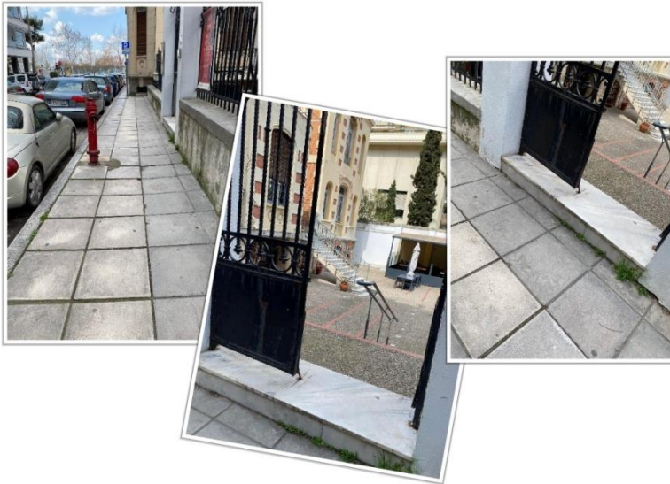
Εικόνα 37: Απεικόνιση της δεύτερης εισόδου του μουσείου, από την οποία επίσης απουσιάζει σύστημα οδηγού όδευσης τυφλών, που να βοηθά τα άτομα να μεταβούν στην είσοδο που οδηγεί στον αύλειο χώρο του μουσείου και κλιμακοστασίου το οποίο δε συνοδεύεται από κάποιο προειδοποιητικό μπλοκ, γεγονός που ισχύει και για την είσοδο που οδηγεί από τον αύλειο στον εσωτερικό μουσειακό χώρο.
