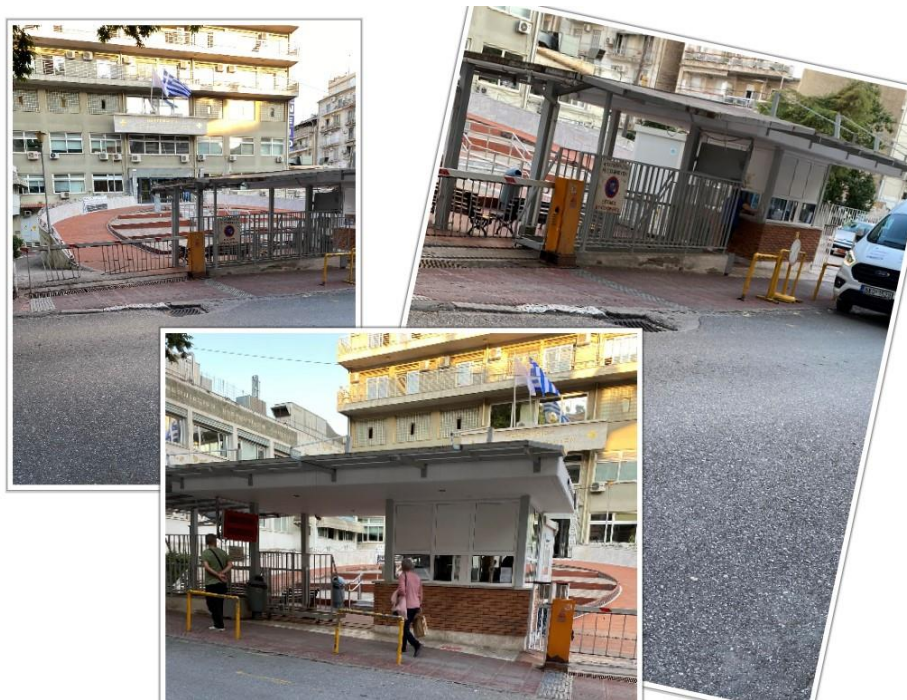
Εικόνα 22: Απεικόνιση της έλλειψης προειδοποιητικών πλακιδίων στην είσοδο του νοσοκομείου
