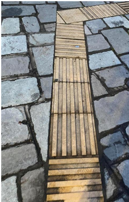
Εικόνα 41: Απεικόνιση της λανθασμένης φοράς του πλακιδίου τύπου Α-ΚΑΤΕΥΘΥΝΣΗ σε ορισμένα σημεία του οδηγού
