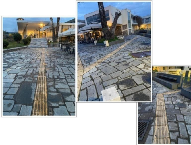
Εικόνα 40: Απεικόνιση του συστήματος οδηγού όδευσης τυφλών, που οδηγεί το άτομο τόσο προς το κτήριο του μουσείου, όσο και προς το αναψυκτήριο που βρίσκεται εκεί καθώς και στον εξωτερικό χώρο του μουσείου στον οποίο επίσης υπάρχουν εκθέματα
