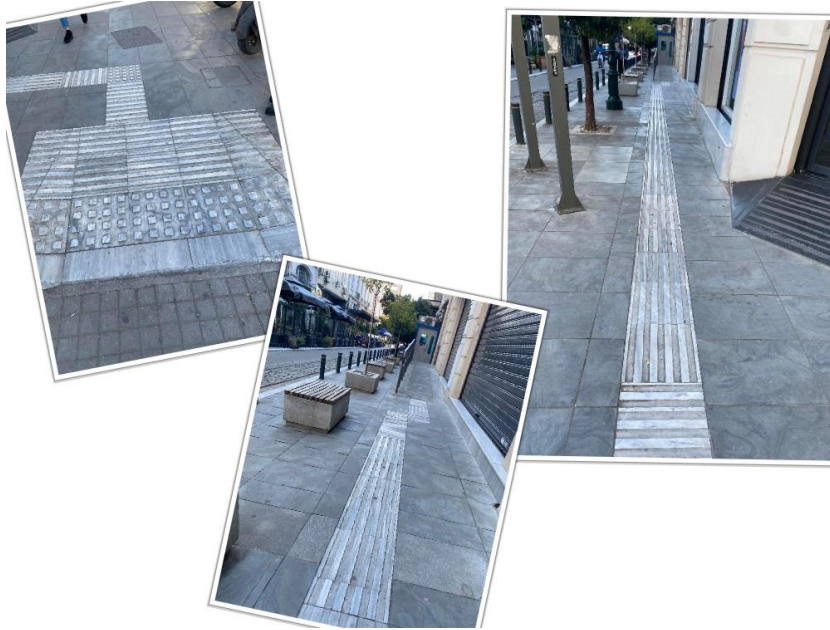
Εικόνα 33 : Απεικόνιση του συστήματος οδηγού όδευσης τυφλών από την έναρξη του πεζοδρομίου και έως τη ράμπα που οδηγεί στην είσοδο του μουσείου
