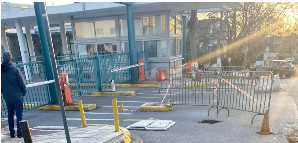
Εικόνα 16: Απεικόνιση των διαζωμάτων που υπάρχουν στην είσοδο του νοσοκομείου ,όπου και απουσιάζουν τα αντίστοιχα προειδοποιητικά πλακίδια
