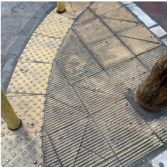
Εικόνα 21: Απεικόνιση κολώνας που βρίσκεται στο κέντρο των πλακιδίων, εμποδίζοντας ,έτσι, τον πιθανό χρήστη
