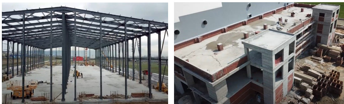
Εικόνα 12: Φέρων οργανισμός κτιρίου αποθήκης (αριστερά) και κτιρίου γραφείων (δεξιά).
