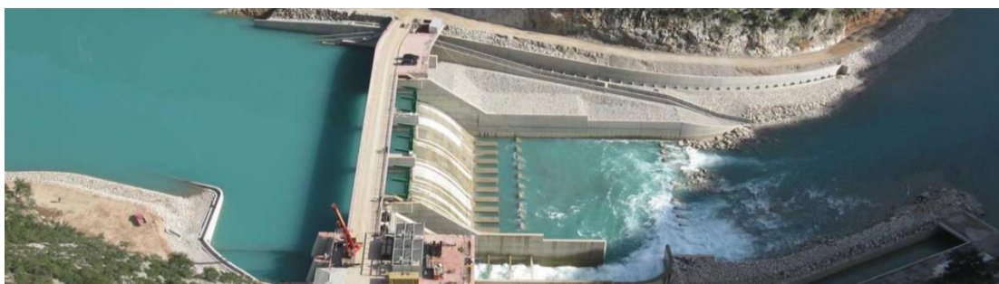
Εικόνα 2: Υδροηλεκτρικό έργο ΜΥΗΕ Δαφνοζωνάρα-Σανίδι
