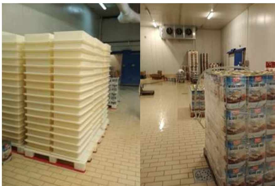
Εικόνα 5.9: Θάλαμοι ωρίμανσης τυριών
