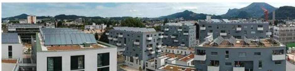
Εικόνα 1 : Συλλέκτες στις οροφές κτιρίων
