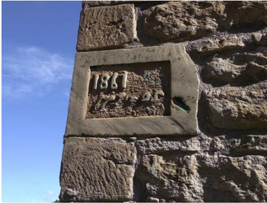
Εικόνα 4 : Αγκωνάρι παλαιού πέτρινου σπιτιού στο οποίο αναγράφεται η ημερομηνία δόμησης
