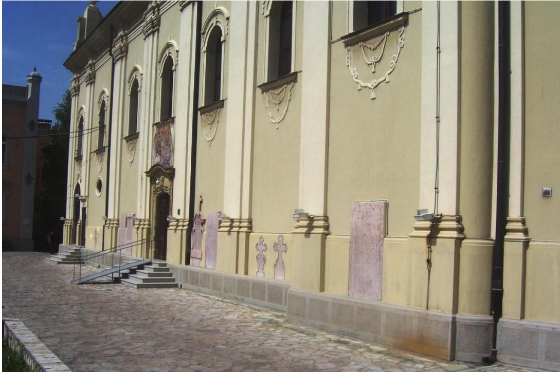
Ναός Γεννήσεως της Θεοτόκου. Νότια πλευρά με τις εντοιχισμένες επιτύμβιες στήλες. Πηγή: Επιτόπια έρευνα. Μάιος 2015.
