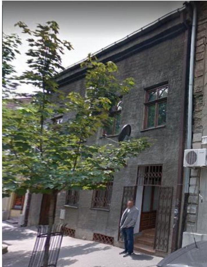
Οικία Σούταρη. Dubrovačka 8. Πηγή: Google street view.
