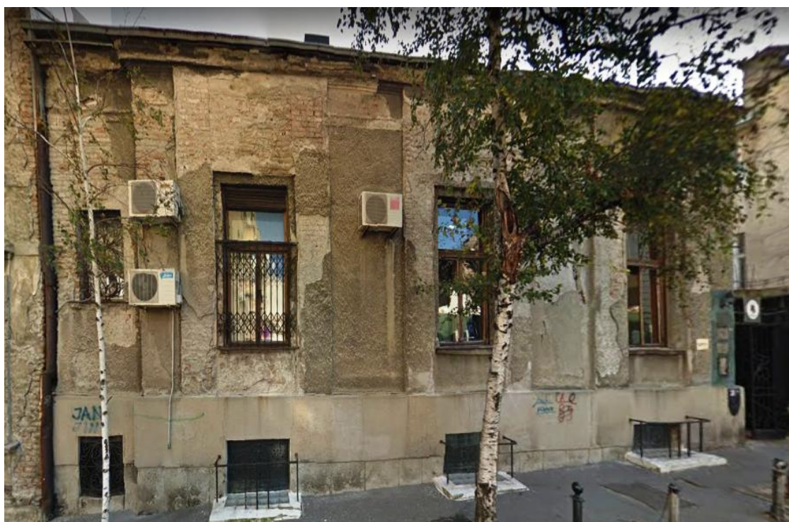
Οικία Περικλή Μπαρμπέρη (Φυρε Daničića 4). Πηγή: Επιτόπια έρευνα. Ιούνιος 2013.
