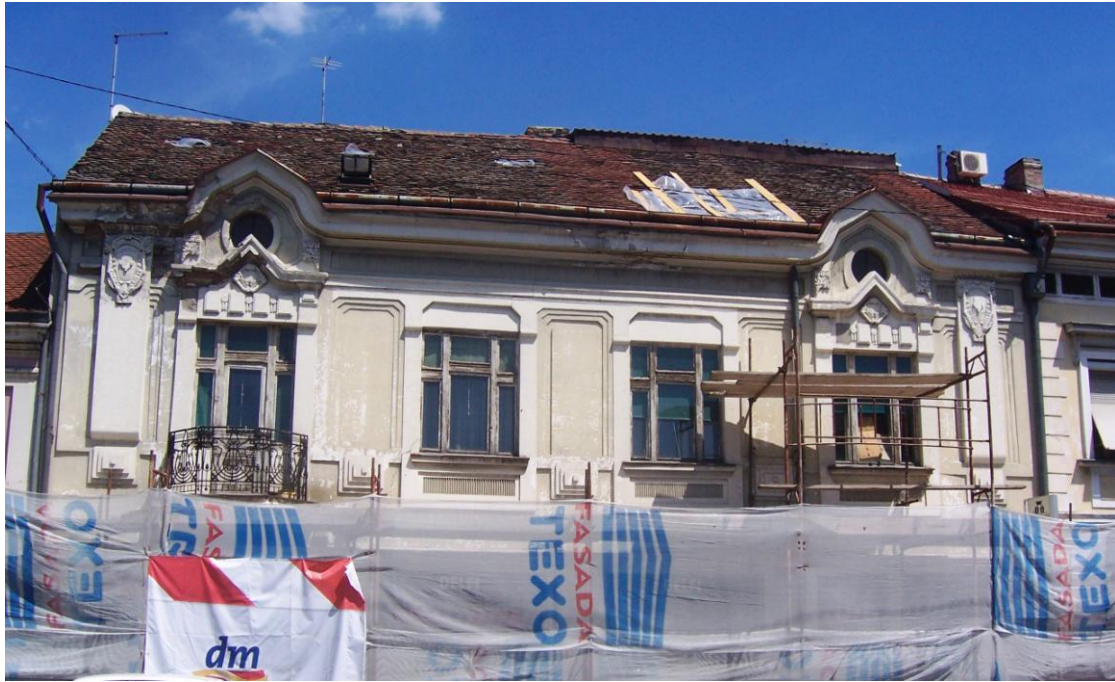
Οικία Πέτροβηκ. Glavna 20. Κατά την διάρκεια των εργασιών για την ανακαίνιση της πρόσοψης. Πηγή: Επιτόπια έρευνα. Μάιος 2015.
