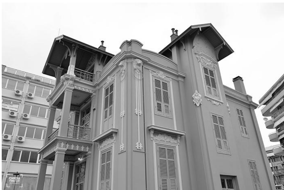
Εικ. 147. Βίλλα Πετρίδη, άποψη μετά την ανακαίνιση ( https://thessarchitecture.wordpress.com )
