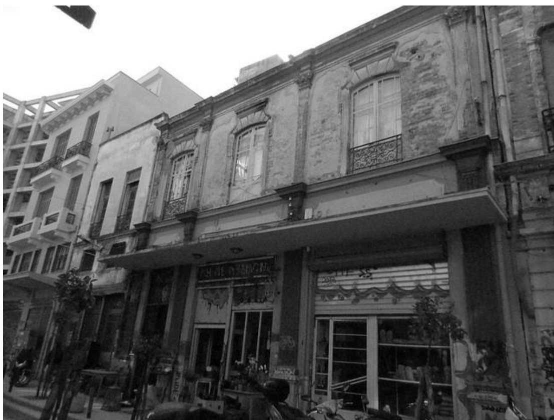
Εικ. 77. Εδέσσης 6, άποψη του κτιρίου ( https://thessarchitecture.wordpress.com )
