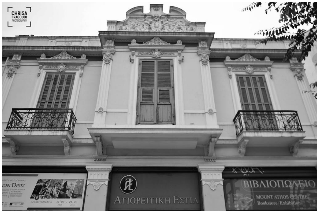
Εικ. 146. Κτίριο Νεδέλκου, κεντρική όψη ( https://thessarchitecture.wordpress.com )
