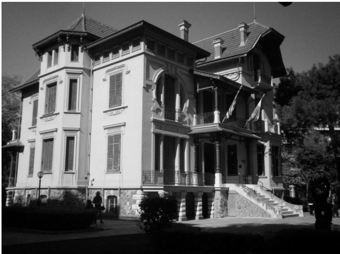
Εικ. 134. Κάζα Μπιάνκα, εξωτερική όψη ( https://thessarchitecture.wordpress.com )
