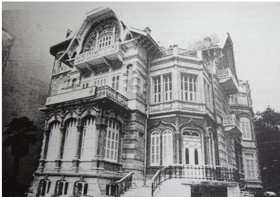
Εικ. 90. Βίλα Γιουσσούφ και Αχμέτ Καπαντζή, άποψη (Νεώτερα μνημεία Θεσσαλονίκης)
