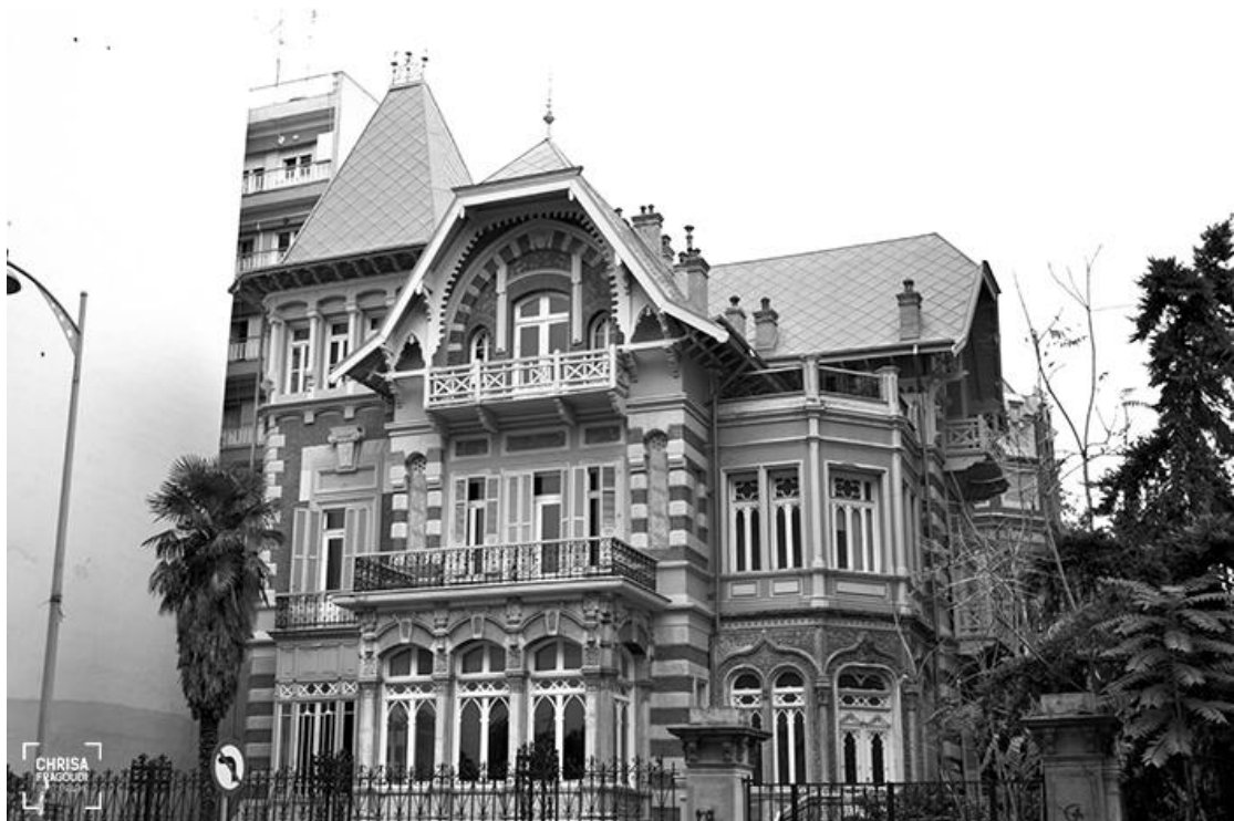
Εικ. 97. Βίλα Αχμέτ Καπαντζή, άποψη ( https://thessarchitecture.wordpress.com )
