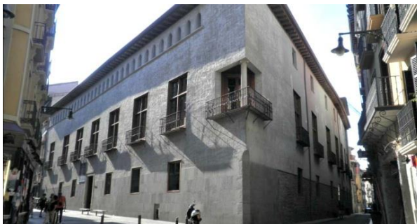
Εικόνα 4: el Palacio del Condestable
