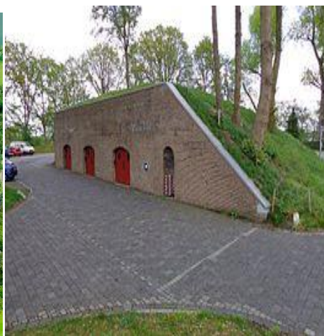
Εικόνα 11: Κτίσμα εντός του στρατοπέδου
