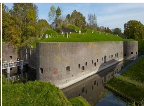
Εικόνα 17: Κτίσμα εντός του στρατοπέδου
