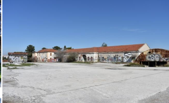
Εικόνα 42: κτίριο Κέντρου Ψυχαγωγίας Μονάδας
