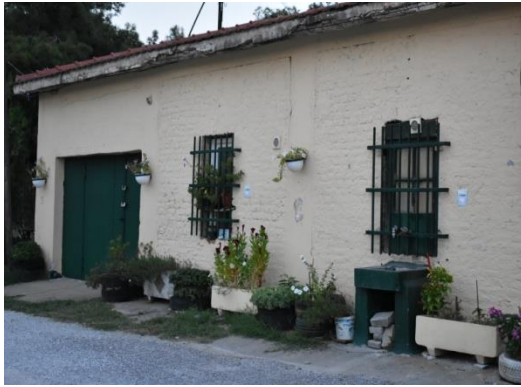
Εικόνα 57: Κτίριο σε καλή κατάσταση
