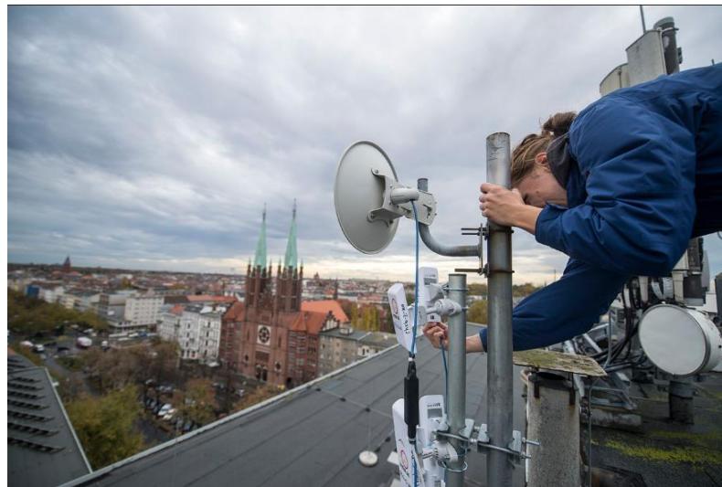
Εικόνα 5-3: Εγκατάσταση κεραιών Freifunk
