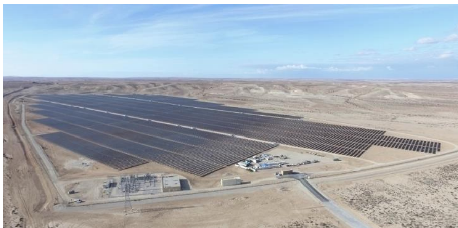
Εικόνα 13: Η φωτοβολταϊκή εγκατάσταση στο ηλιακό συγκρότημα Ashalim,
