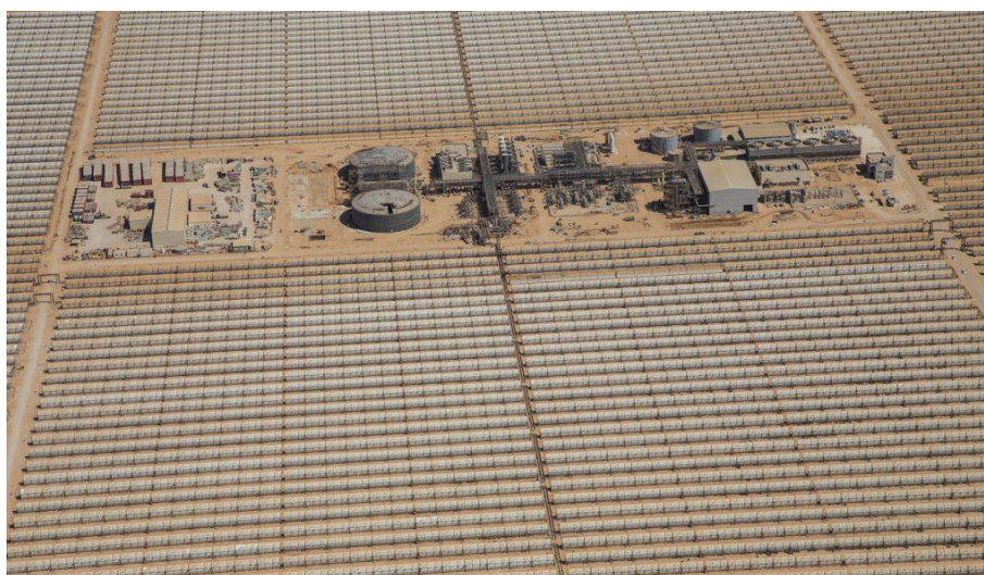
Εικόνα 8: Ο θερμοηλεκτρικός ηλιακός σταθμός Ashalim Plot A,
