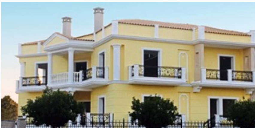
Εικόνα 2 Εξωτερική όψη διώροφης διπλοκατοικίας στη Λάρισα
