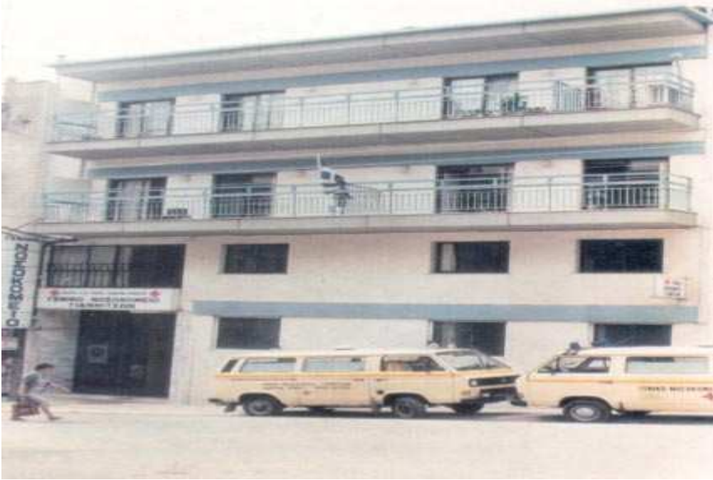
Γενικό Νοσ/μείο Γιαννιτσών (κτίριο Σιγανίδη) 1985- 1993
