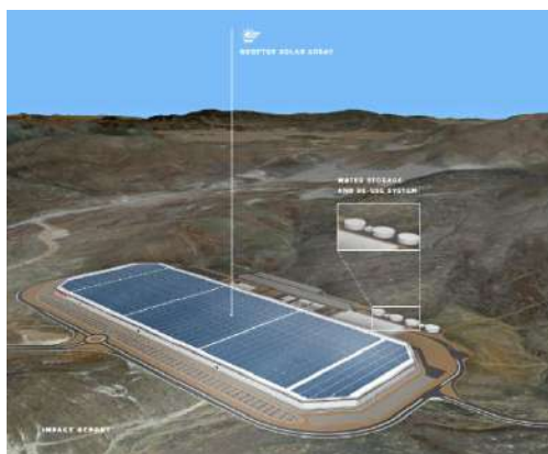
Εικόνα 6 Συστοιχία φωτοβολταϊκών στο Gigafactory και σύστημα αποθήκευσης και επαναχρησιμοποίησης νερού
