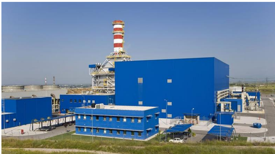
Εικόνα 2.8: Εργοστάσιο παραγωγής ηλεκτρικής ενέργειας στη Θεσσαλονίκη.
