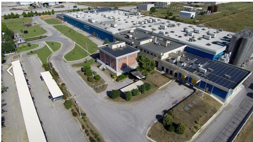
Εικόνα 2.4: Βιομηχανικές εγκαταστάσεις της ΔΙΑΧΟΝ.
