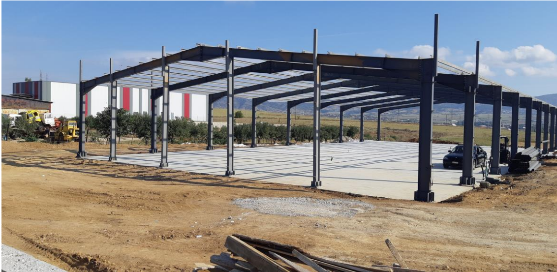
Εικόνα 21 Ολοκλήρωση της υποστύλωσης, Οκτώβριος 2020
