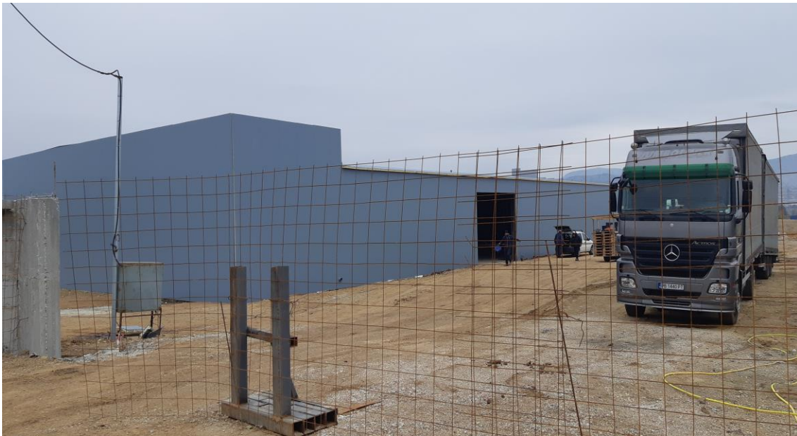
Εικόνα 24 Εξωτερική όψη εργοστασίου
