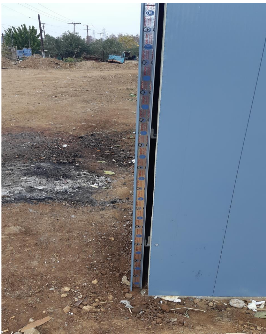
Εικόνα 22 Αποκόλληση μεταλλικών πάνελ
