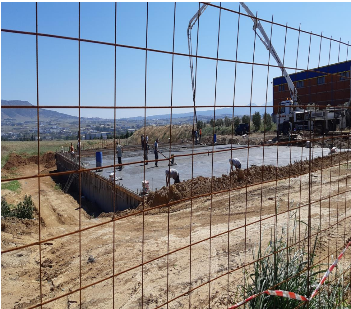
Εικόνα 20 Μηχάνημα εκτοξευόμενου σκυροδέματος
