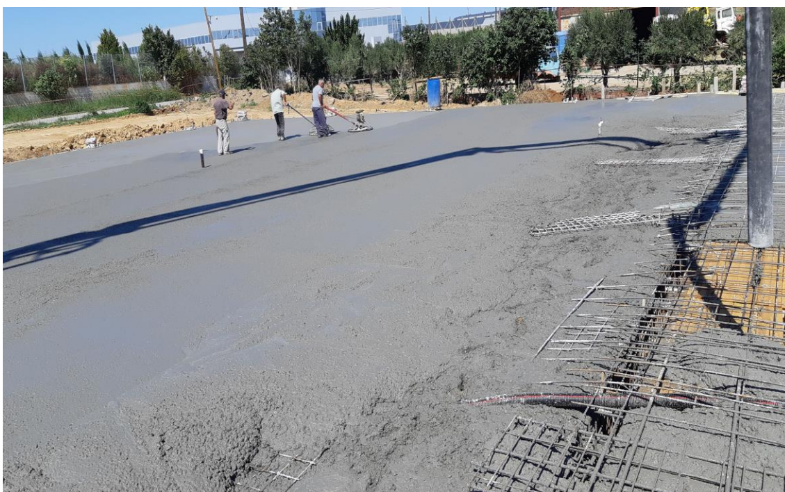
Εικόνα 19 Σκυροδέτηση κάτω πλάκας βιοτεχνίας
