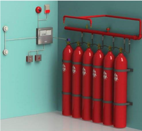
Εικόνα 1: Το σύστημα πυρόσβεσης
