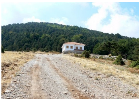
Εικόνα 9: Καταφύγιο στην περιοχή «Κρεβάτια» Βροντούς
