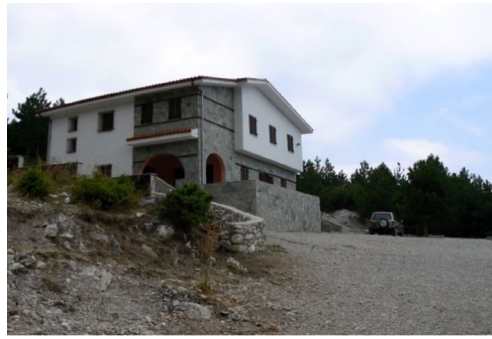
Εικόνα 10: Καταφύγιο στην περιοχή "Κορομηλιά" Δίου
