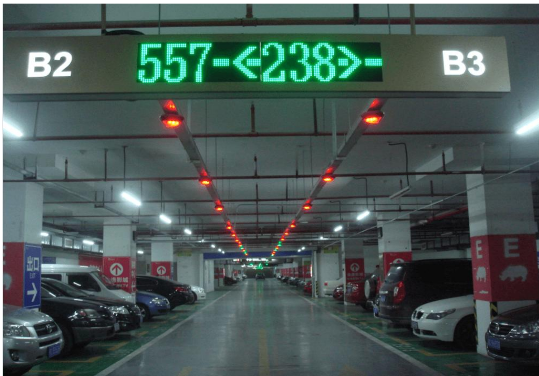
Εικόνα 8: Οι τεχνολογίες Overhead Guidance Indicators και VMS [23].
